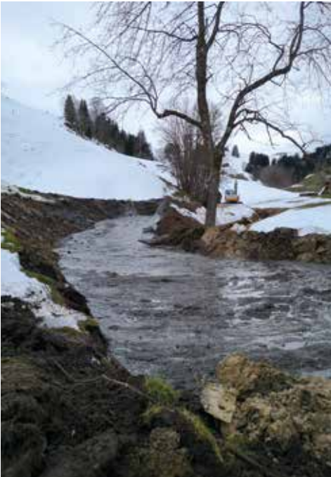
Massenweise Schlamm, der aus dem Feuer- wehrweiher ausgebaggert wurde.
