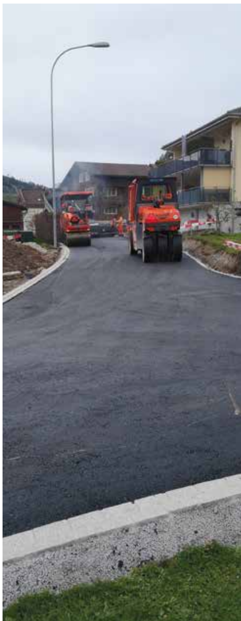
Strassenarbeiten beim Loretto. (Bild: Thomas Schefer)
