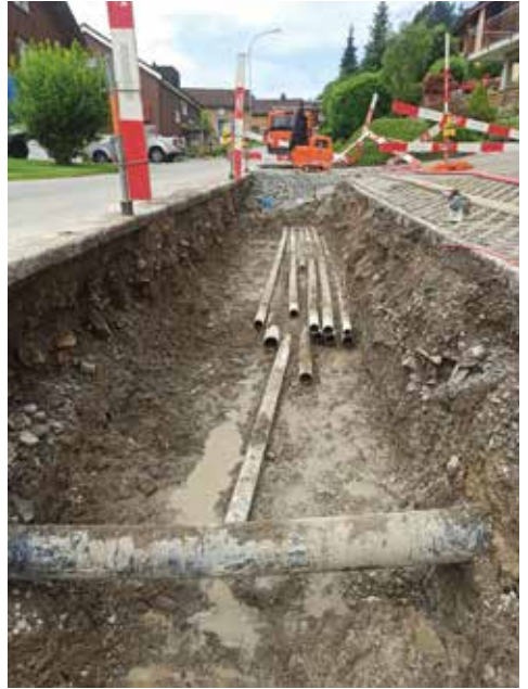
Die Werkleitungen unter der Loretto-Strasse mussten aufwendig ersetzt werden.
